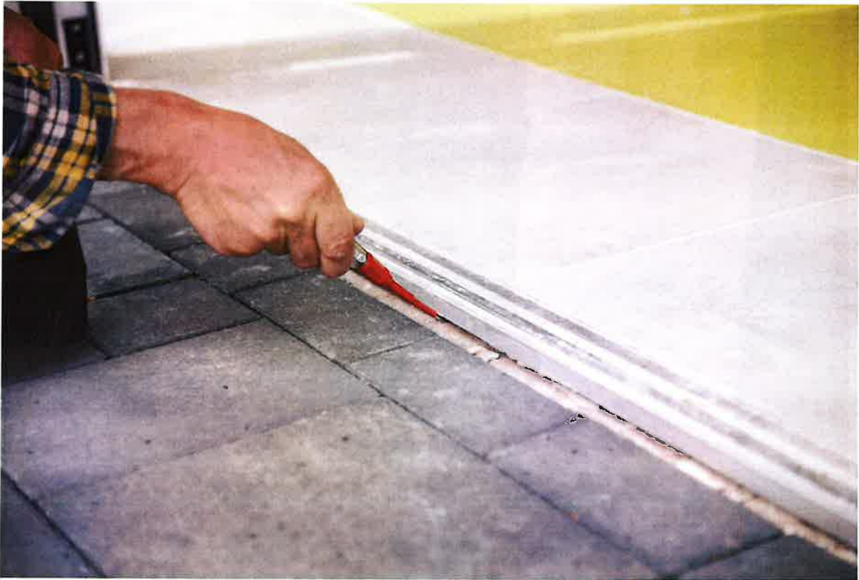
Luźne progi w drzwiach zewnętrznych do sal zajęciowych.
