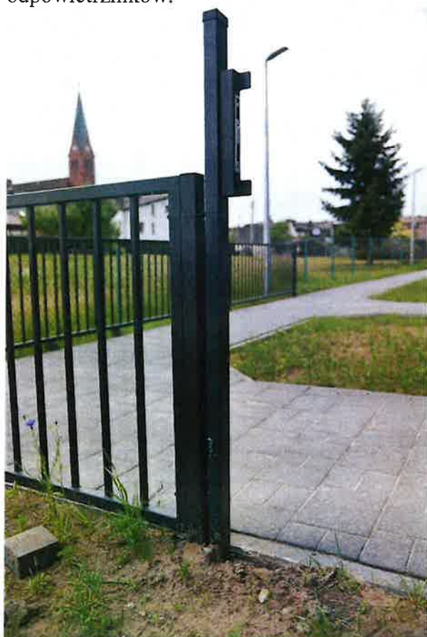
Słupek od furtki jest luźny, można go z łatwością wyjąć.
