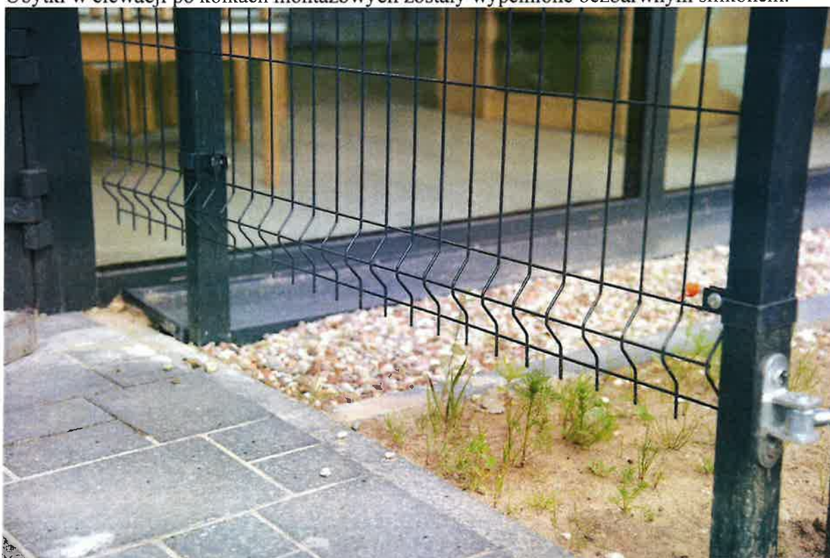
Przęsło płotu przy furcie zostało zamontowane za wysoko lub jest po prostu za niskie.
