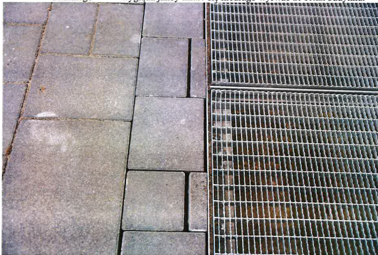
Przed wejściem znajduje się luźna kostka brukowa, niewypełniona piaskiem.
