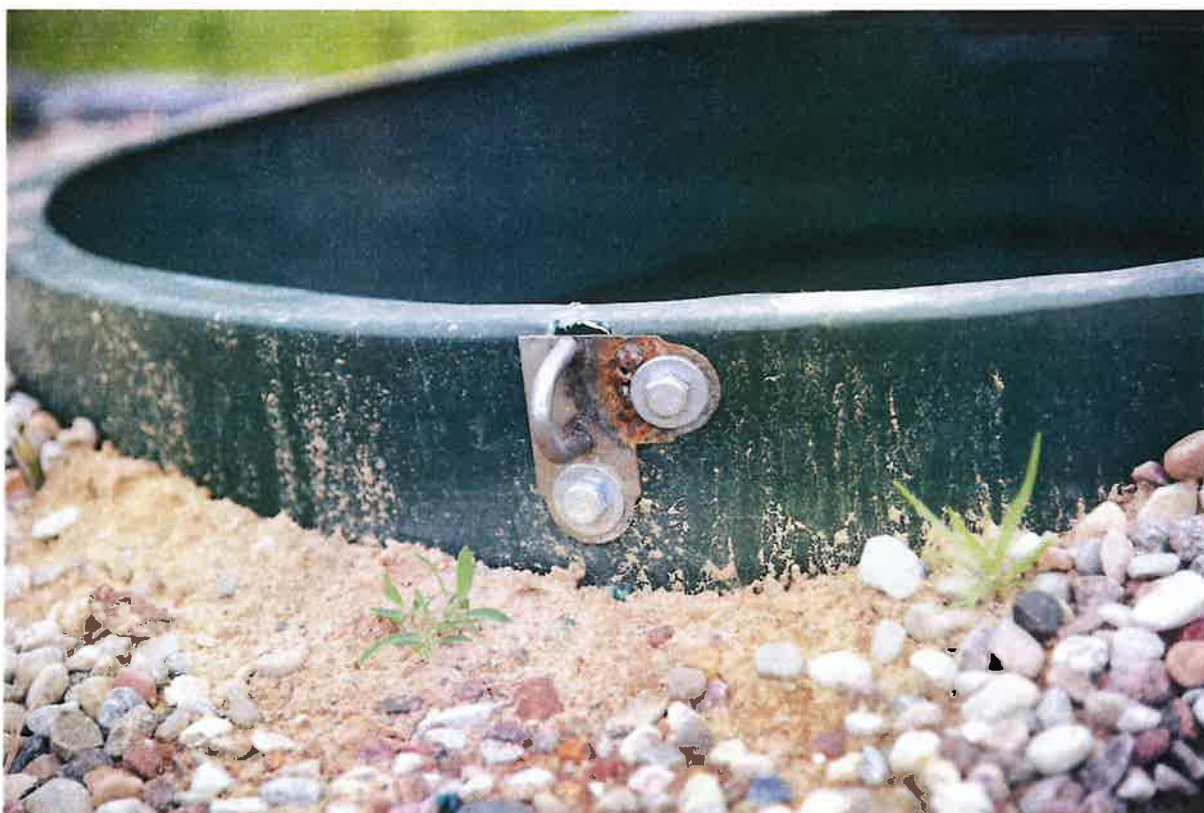
Zamek do komory zbiornika z gazem został wyłamany. Woźni dorobili własne zamknięcie.
