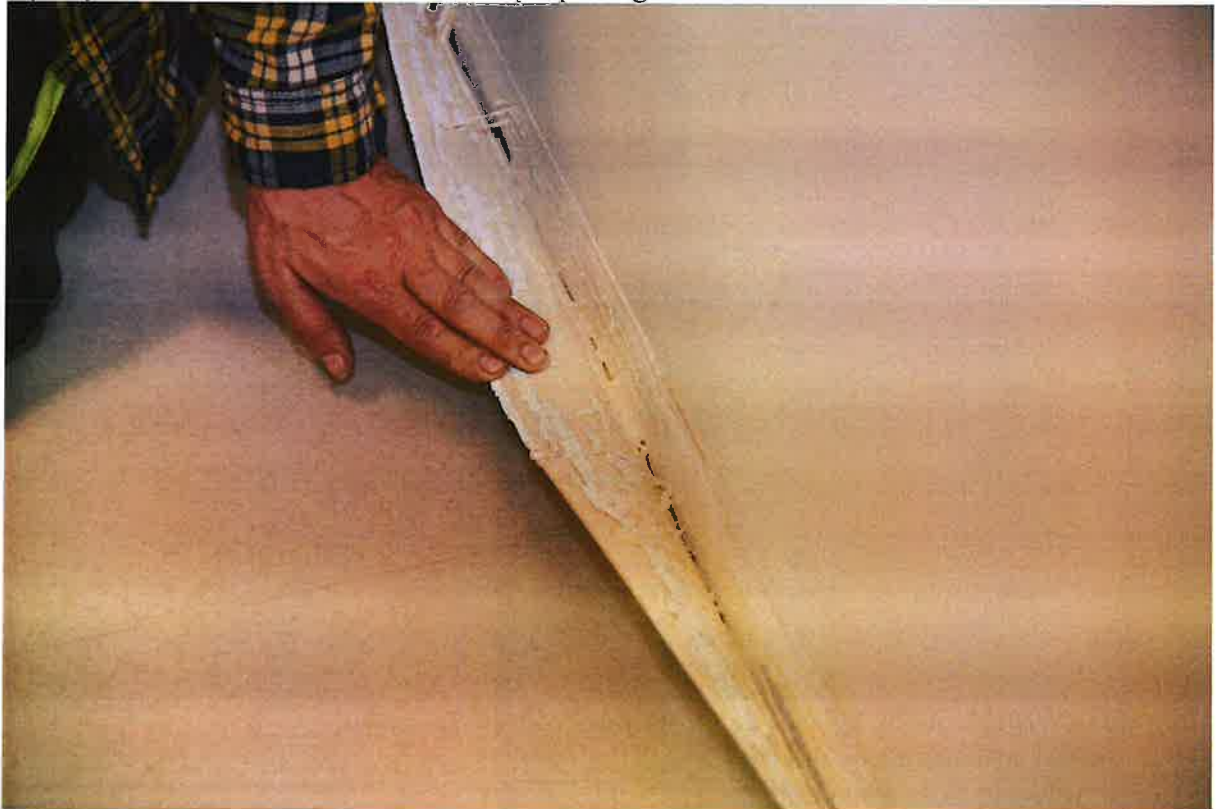
Pęknięcia na framudze drzwi. Odchodząca podłoga.
