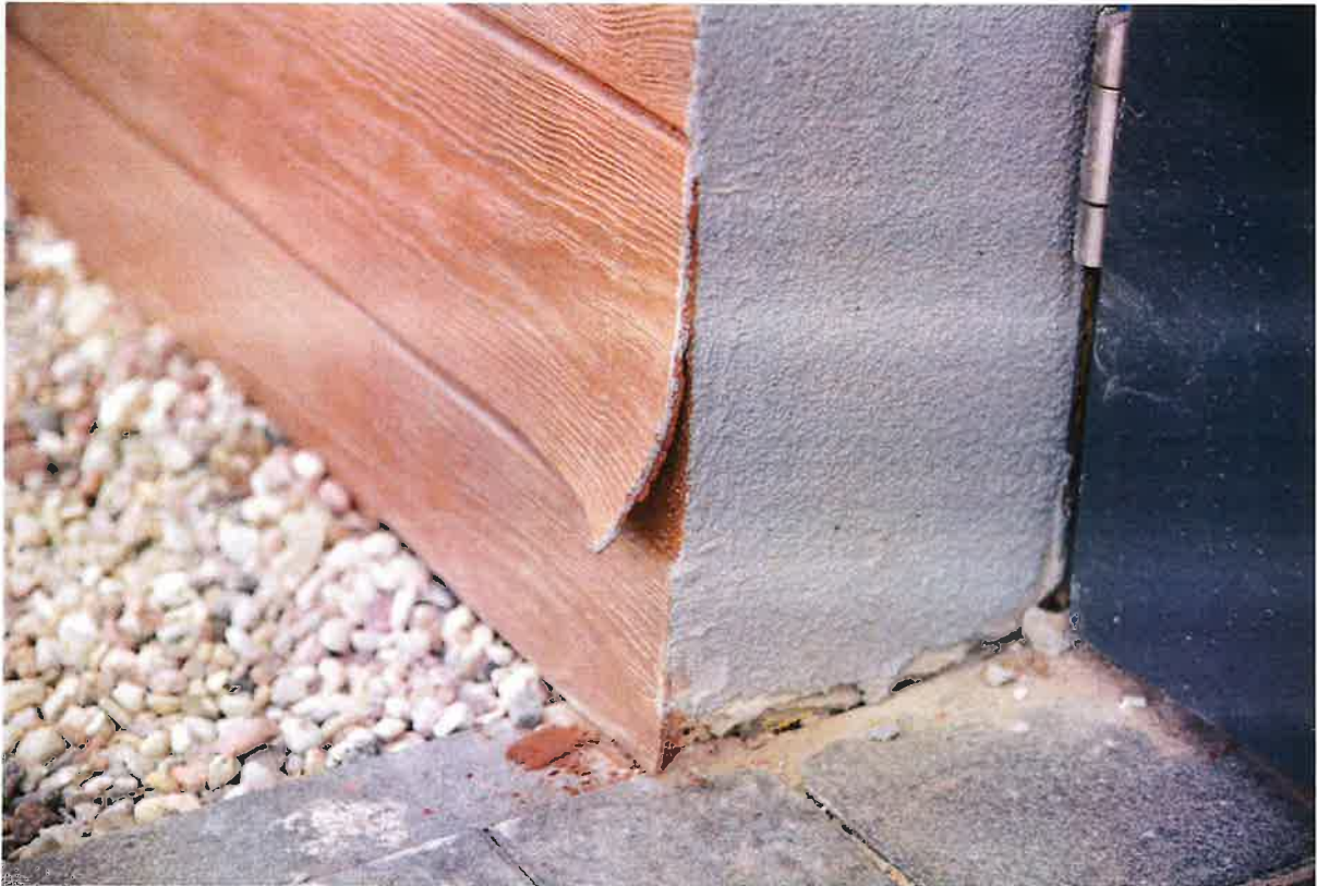
Odchodząca zewnętrzna elewacja budynku.
