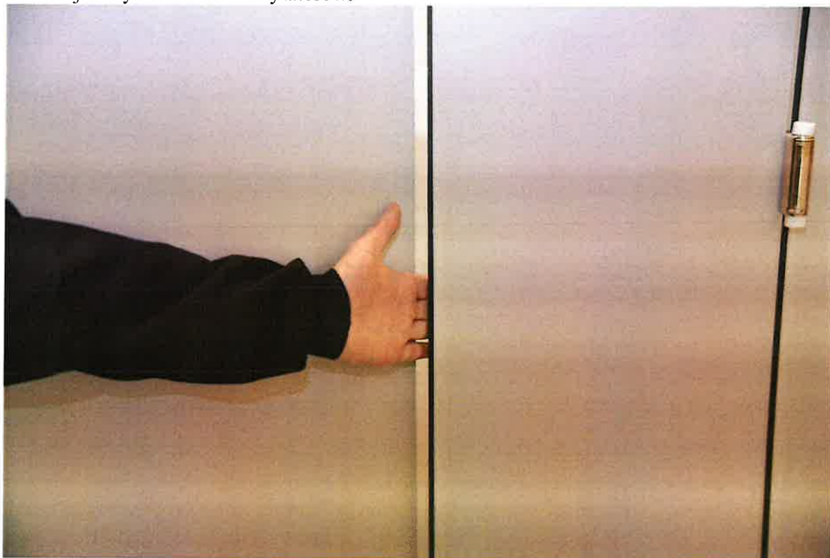
Można przykleścić sobie ręce w drzwiach od kabiny łazienkowej. Kurtyny są luźne.
