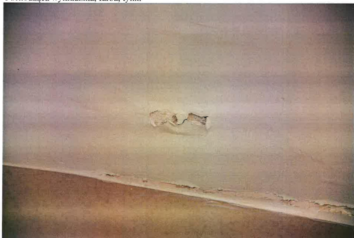
Odchodząca wykładzina, farba, tynk.
