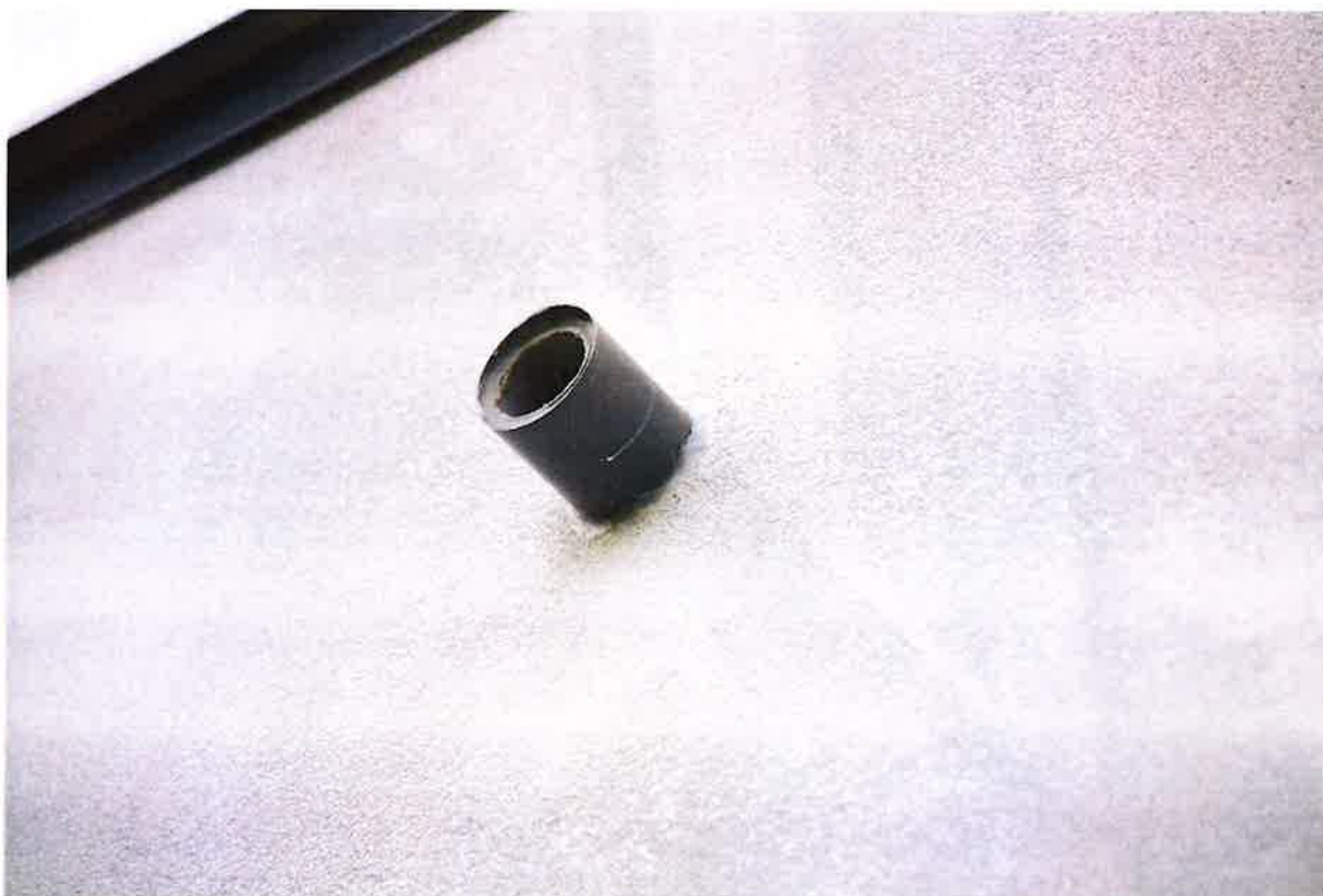
Dodatkowe odpływy wody z dachu obrabione są bezbarwnym silikonem.
