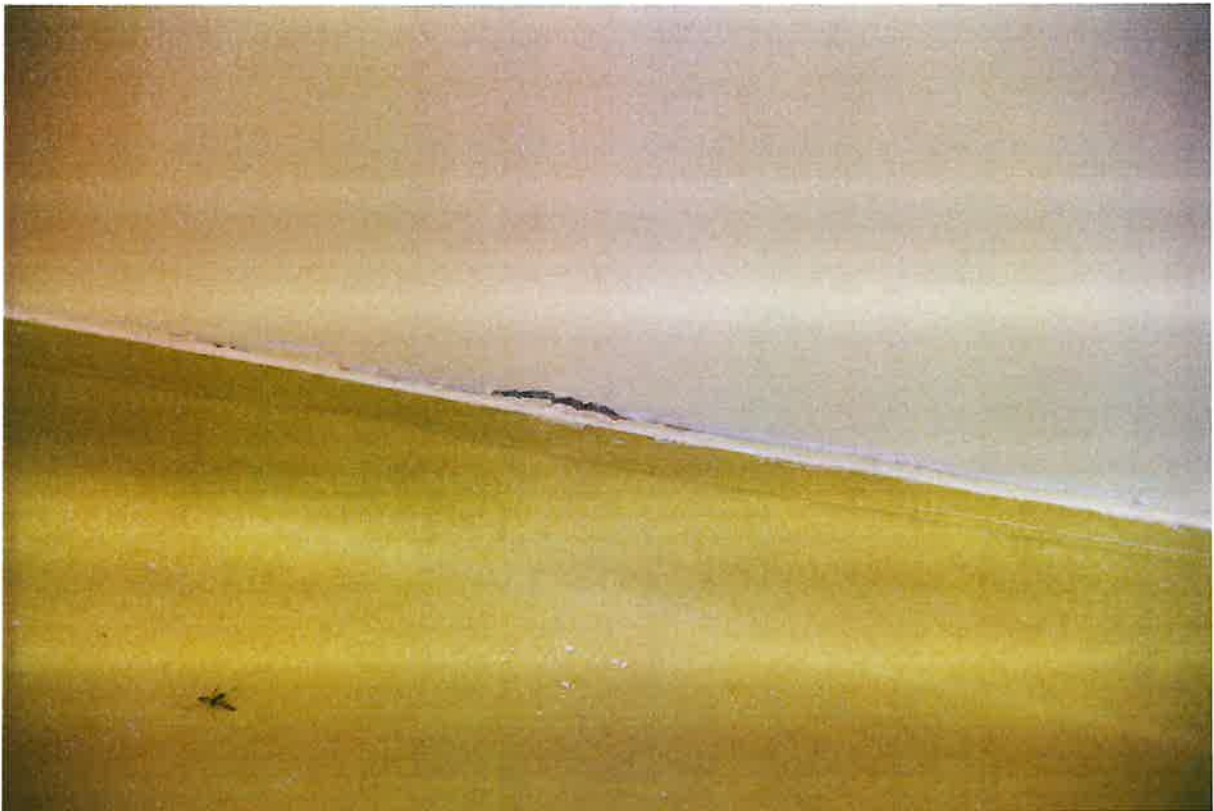
Odchodząca wykładzina, farba – podobnie jak w innych pomieszczeniach.
